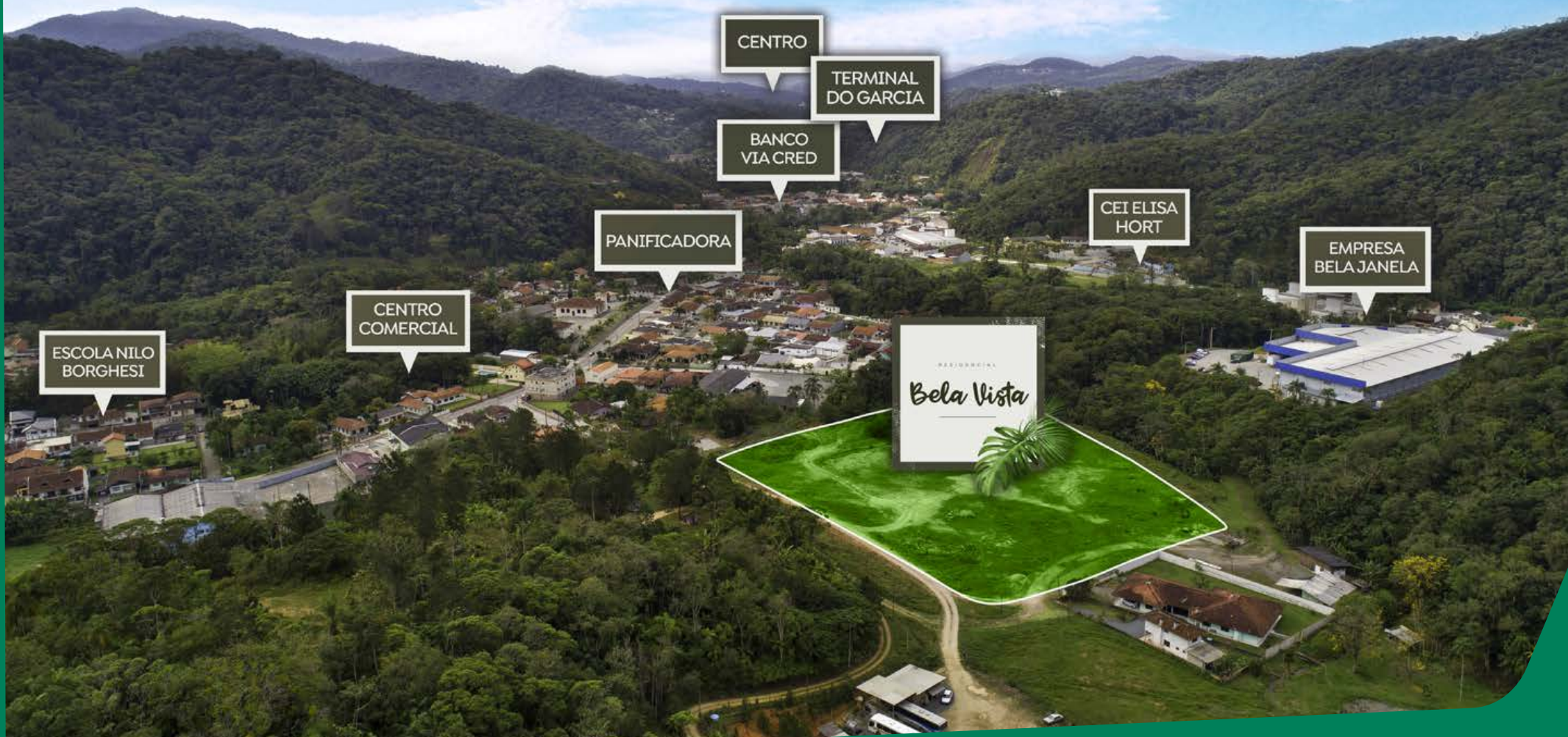
Foto aérea do local
